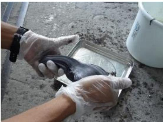
写真 3-8 管口仕上げ材練り混ぜ状況
