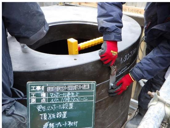
写真3-15 金属プレート取付状況
