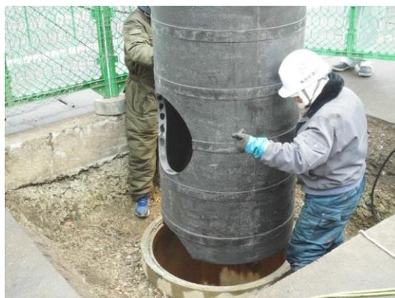
写真3-5 下段直壁設置状況
