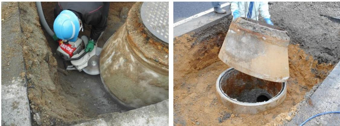
写真 3 - 2 斜壁の撤去状況
