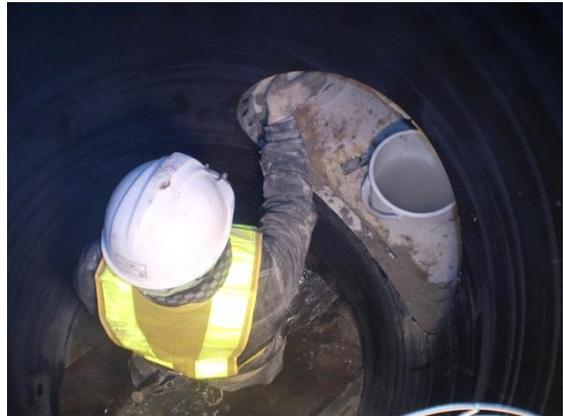
写真 3-7 急結セメント充填状況
