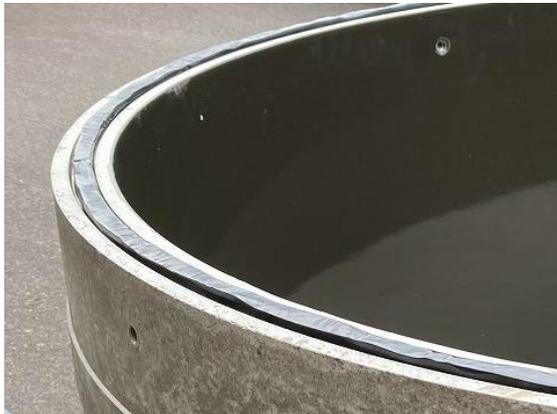
写真4-1 シール材設置状況
