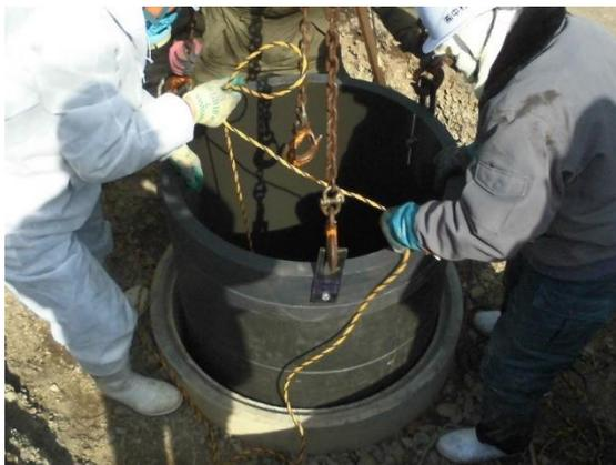
写真3-10 上段直壁設置状況
