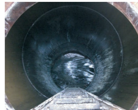
通過マンホール
