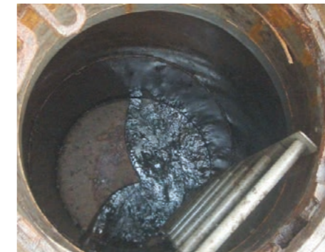
合流マンホール
