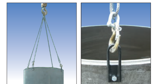
4号マンホール吊り上げ状況
