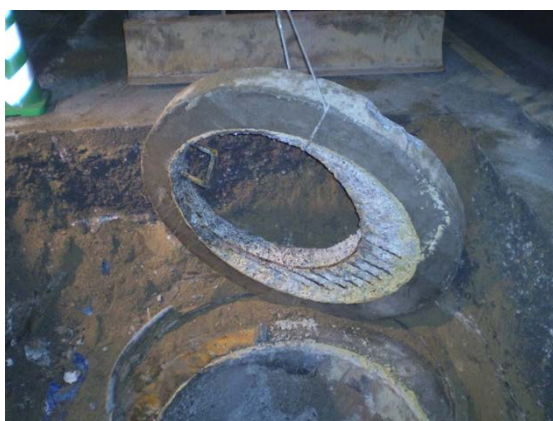
写真3-2 蓋および受け枠の撤去
