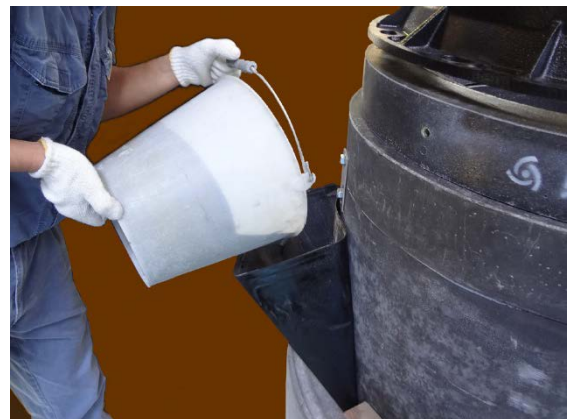
大型簡易漏斗をもちいた充てん
