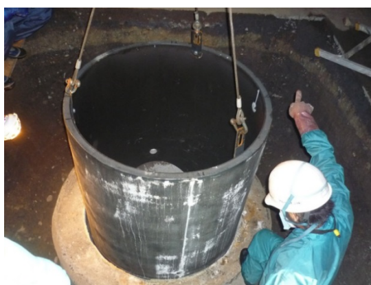
写真3-10 直壁設置状況
