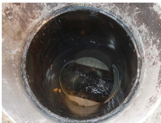
写真3-16 エポキシ充てん接着剤塗布完了
