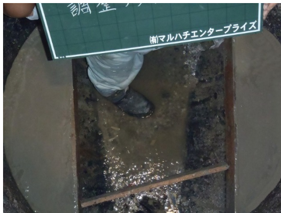
写真3-6 レベル調整状況
