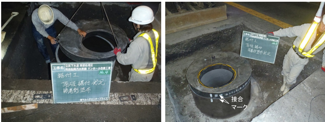
写真3-21 頂版設置状況
