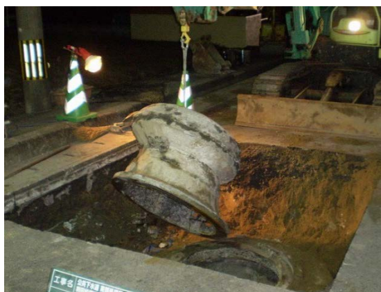
写真3-3 斜壁の撤去
