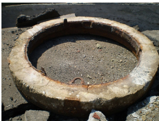
写真3-2 蓋および受け枠の撤去
