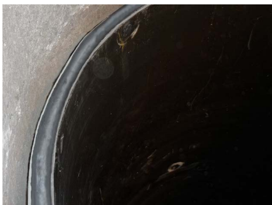
写真3-15 エポキシ充てん接着剤塗布状況
