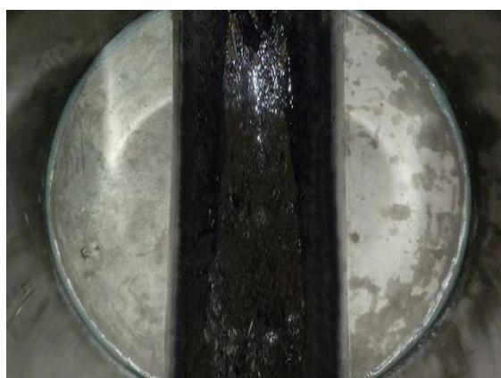
写真3-12 直壁接着部仕上げ (直壁設置後, 樹脂パテすり付け)
