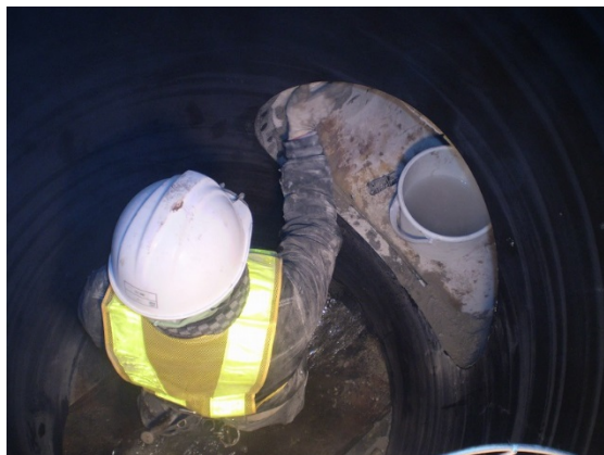
写真3-14 急結セメント充てん状況
