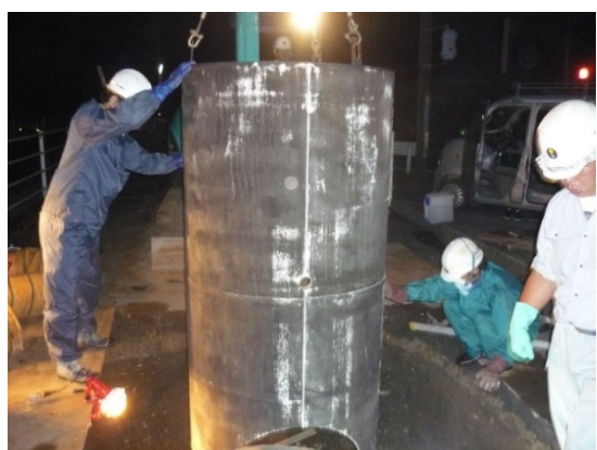
写真3-10 直壁設置状況
