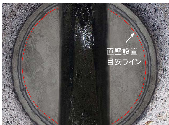
写真3-11 エポキシ充てん接着剤塗布 (直壁設置前)
