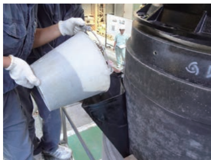
グラウト材充てん状況
