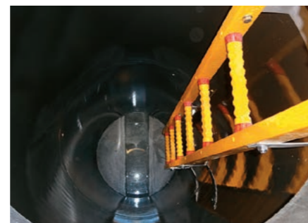
更生後のマンホール内面状況
