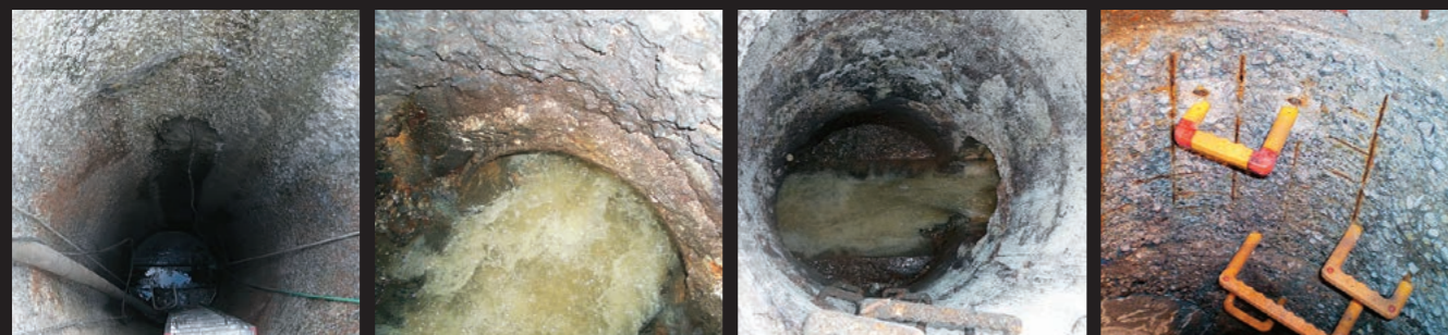
(更生前の腐食マンホール)
