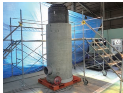
施工完了状況
