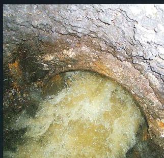
(更生前の腐食マンホール)
