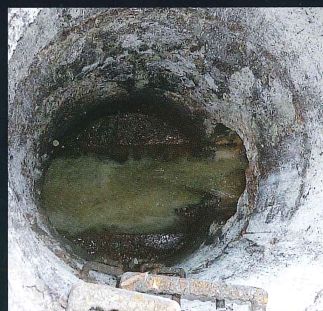
(更生前の腐食マンホール)
