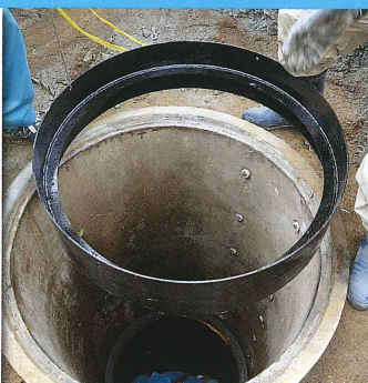
連 結 リ ン グ 設 置
