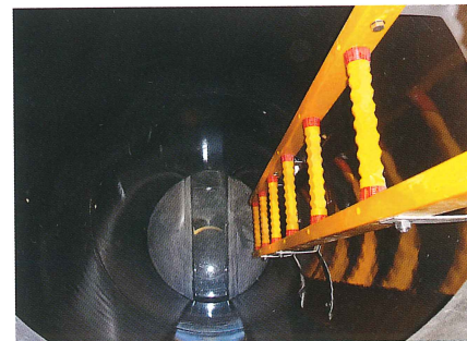
更生後のマンホール内面状況
