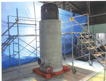
施工完了状況
