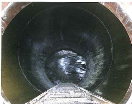
通過マンホール
