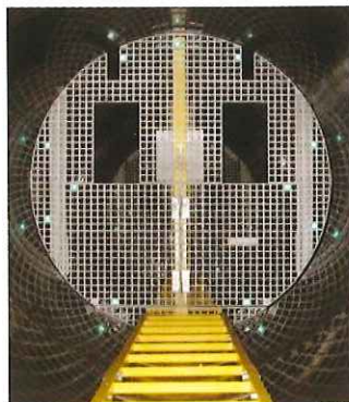
マンホールポンプ用 FRP製スラブ取付例
