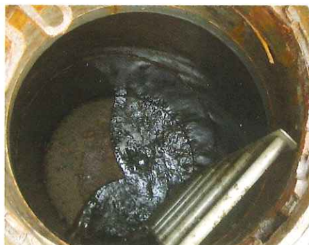
合流マンホール
